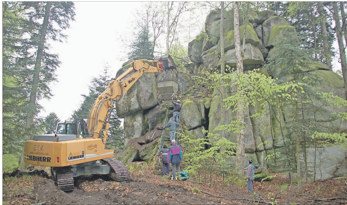
Gestern Vormittag in schwierigem Gelände: Die Treppe zum Aussichtsplateau Bärenstein wird neu befestigt.
