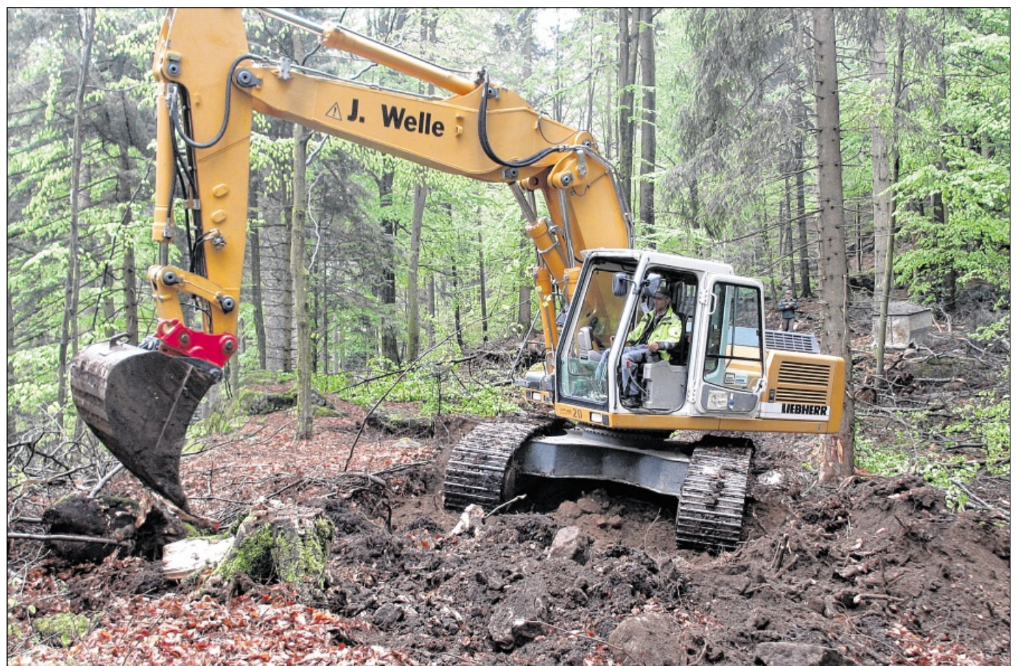
BAGGEREINSATZ: Gleich mehrere große Felsbrocken mussten wegen der Sanierung der Treppe, die zur Burg Bärenstein führt, versetzt werden.
