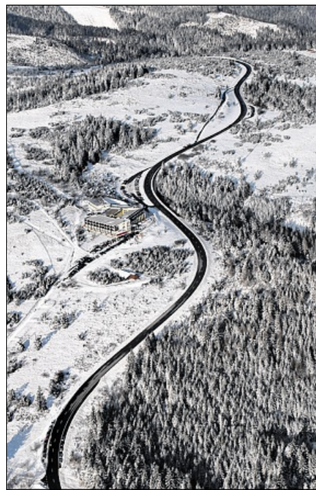
DIE B 500 aus der Vogelperspektive: In der Mitte des Bildes liegt links das Schliffkopfhotel. Luftbild: Grohe/ Grafik: Schlaich
